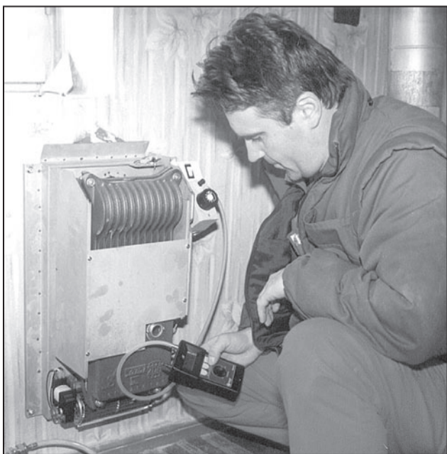
Последни довършителни работи по свързване жилището на Иванка Велчева към градската газопрепосна мрежа
